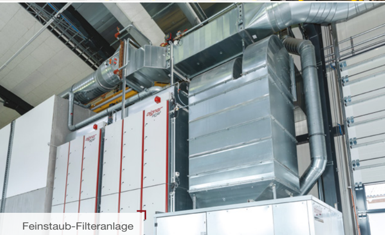
Patronenfilter-Anlage mit Wärmerückgewinnung
