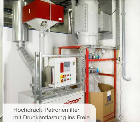
Schweißrauchabsaugung mit Patronenfilter und Brandlöschanlage
